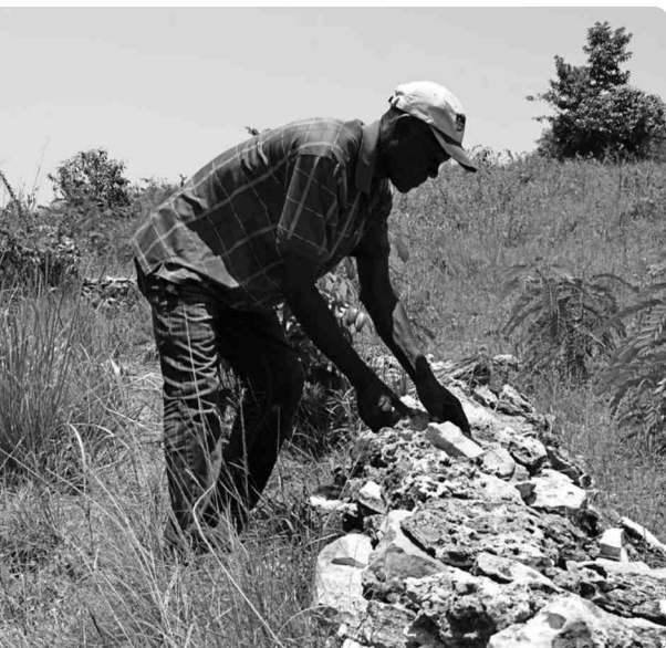
Bereits heute machen sich die Folgen des Klimawandels deutlich bemerkbar – in Haiti errichten die Bauern Steinmüerchen, um die weitere Erosion des Bodens durch Überschwemmungen zu verhindern. Foto: Fastenopfer
